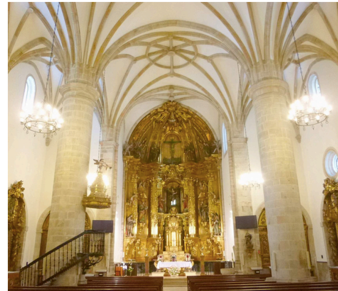
Fig 7. Miguel de Abaría. Bóvedas de la parroquia de San Miguel, 1672, Idiazábal. Fotografía del autor
