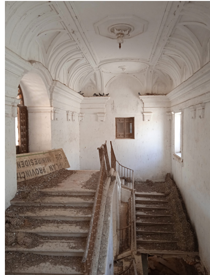
Fig. 9. Aspecto actual de la escalera de la Casa de las Torres. Tembleque. Fotografía del autor.
