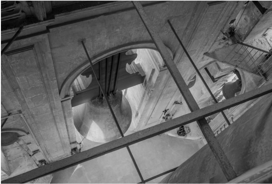
Fig. 11. Torre de la Catedral de Murcia, interior del cuerpo de campanas (Fotografía M. Saura).
