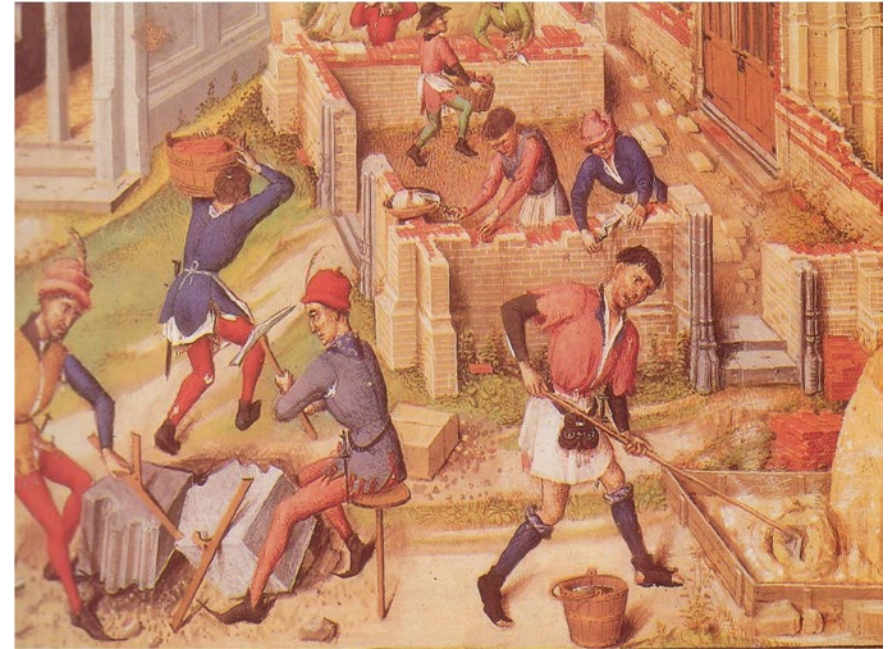
Fig. 12. Canteros construyendo. A la izquierda podemos verlos sentados en unos taburetes que utilizaban para realizar su trabajo de forma más cómoda. Detalle de la miniatura Crónica de Gerard de Roussillon. Construcción de doce iglesias por Gerard y su esposa , ca. 1450. Biblioteca Nacional de Viena, cod. 2549.
