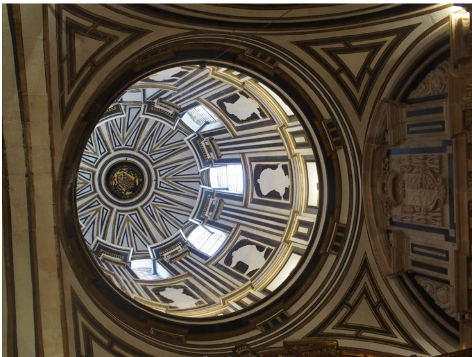
Fig. 2. Linterna de la Capilla de San Enrique, perteneciente a la antigua Capilla de las Reliquias de la Catedral de Burgos.
