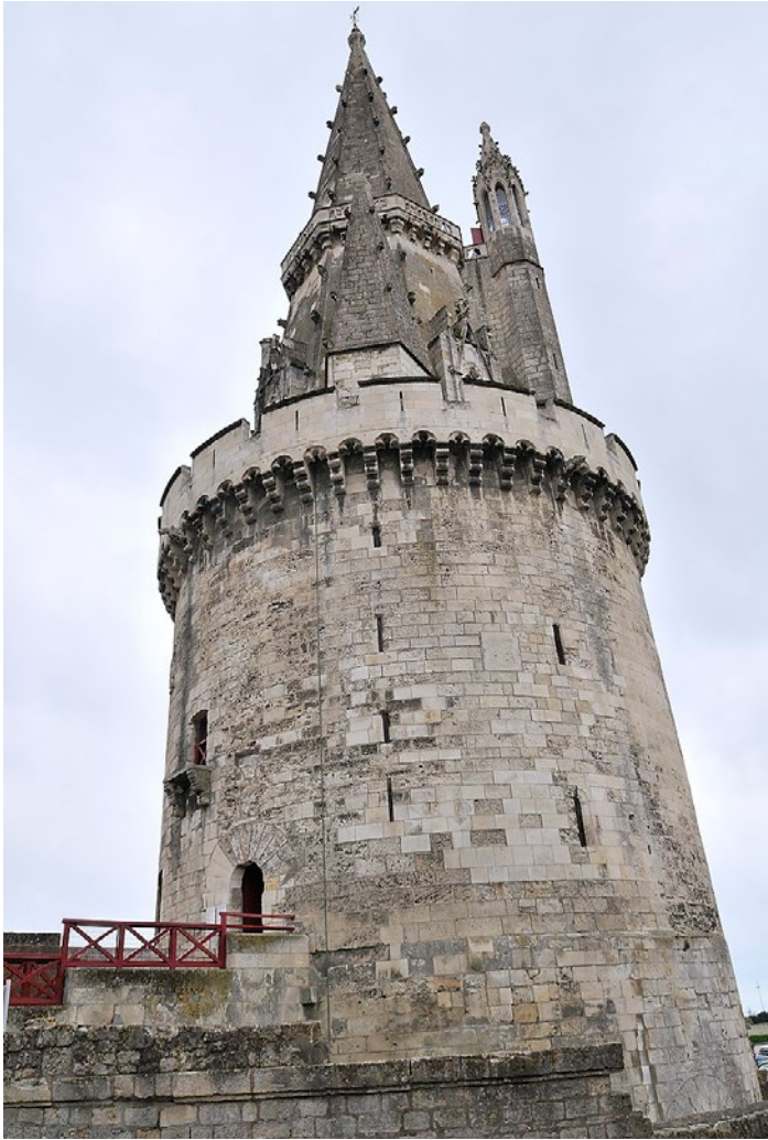
Fig. 17. Torre de la Linterna, o faro del puerto de La Rochelle, siglo XV. Erigida con apoyo del mecenazgo del rey Luis XI, supone la aplicación del tipo de torre rematada con flecha a la construcción civil. Foto: Pablo Herrero Lombardía.
