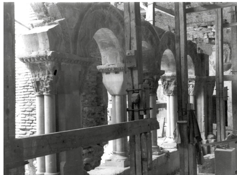
Fig. 4. José Esteban Uranga, Claustro de la catedral de Tudela en restauración. Crujía sur , 1942, Archivo Institución Príncipe de Viana, Pamplona
