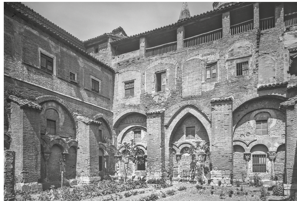
Fig. 1. Claustro de la catedral de Tudela. Vista de las alas oeste y norte, 1932. © Bildarchiv Foto Marbur
